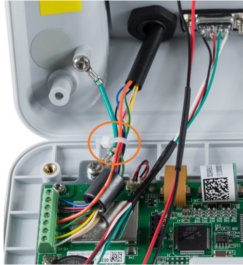
Figura 2-24: Installazione del terminale di messa a terra e della ferrite per la cella di carico analogica, IND231
