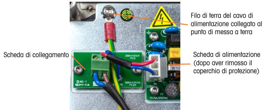
Figura 2-18: Scheda di collegamento dell'alimentazione CA e della terra IND236
